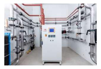
In kühleren Zeiten, während der Heizperiode, sorgt die Schnitzelheizung für Wärme. Die Holzschnitzel stammen aus regionalem Energieholz. Die im Feuer enthaltene Hitze wird durch Rauchgase im Wärmetauscher auf das Heizungswasser übertragen. Anschliessend werden die Rauchgase im Trocken-Partikelabscheider mittels Hochspannung optimal gefiltert.
