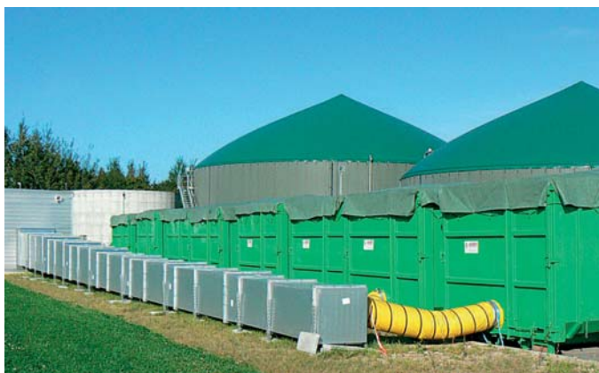
Essiccatore mobile a container alimentato tramite il calore residuo di un impianto a biogas (Moser, 2015)
