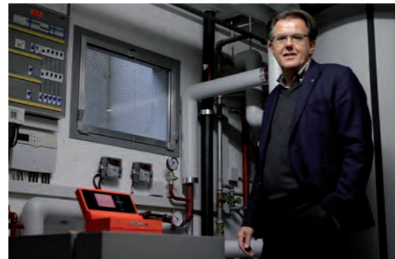
Peter Schilliger präsentiert die Absorberfläche auf dem Dach seines Hauses. Die unverglasten Solar-Luft-Kollektoren sind eine Komponente der Eisspeicher-Anlage.
