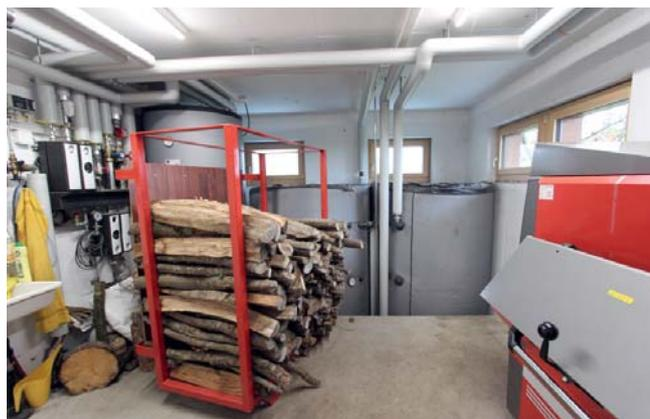
accumulateur d'énergie. Pour éviter les pertes de chaleur, on installe le ballon dans une zone chauffée (p. ex. le local de séchage du linge).
