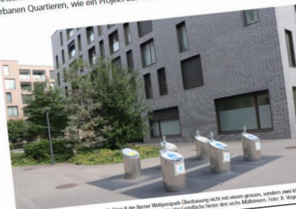
Wird der Platz im Erdreich knapp war, wurde in Bern B der Berner Weltpostpark Überbauung nicht mit einem grossen, sondern zwei B Eisspeichern ausgestattet. Eine von ihnen befindet sich im Erdreich unter der Garafache hinter dem sechste Müllbehälter. Foto: B. Vögeli
