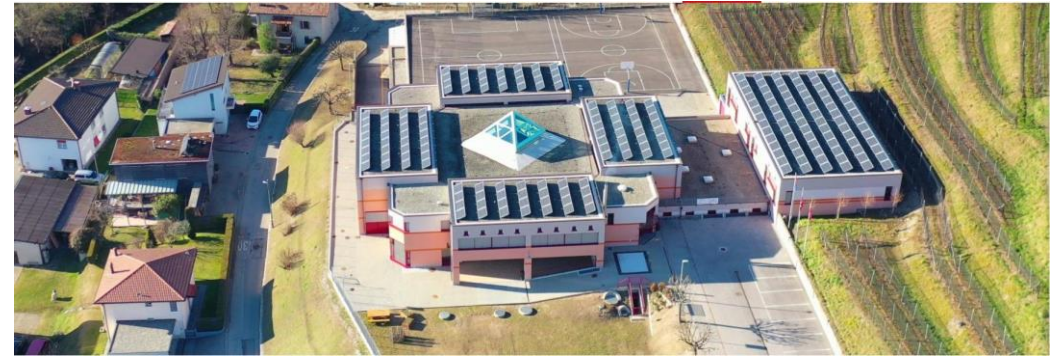
Centro scolastico Castel San Pietro (cippato, fotovoltaico)
