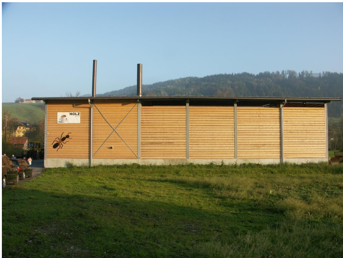
Quelle: Wärmeverbund Urnäsch © Holzenergie Schweiz
